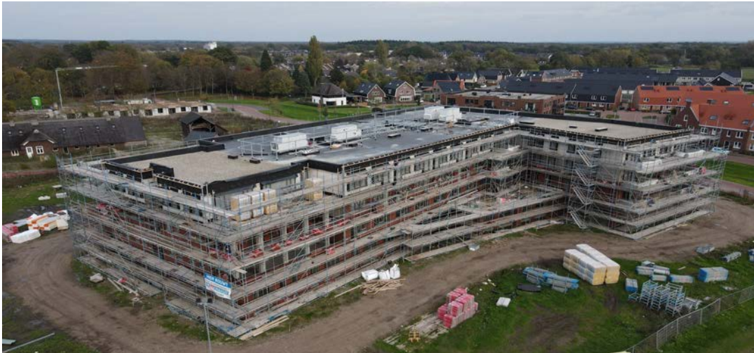
De achterkant van het gebouw, foto gemaakt op 7 november 2022
